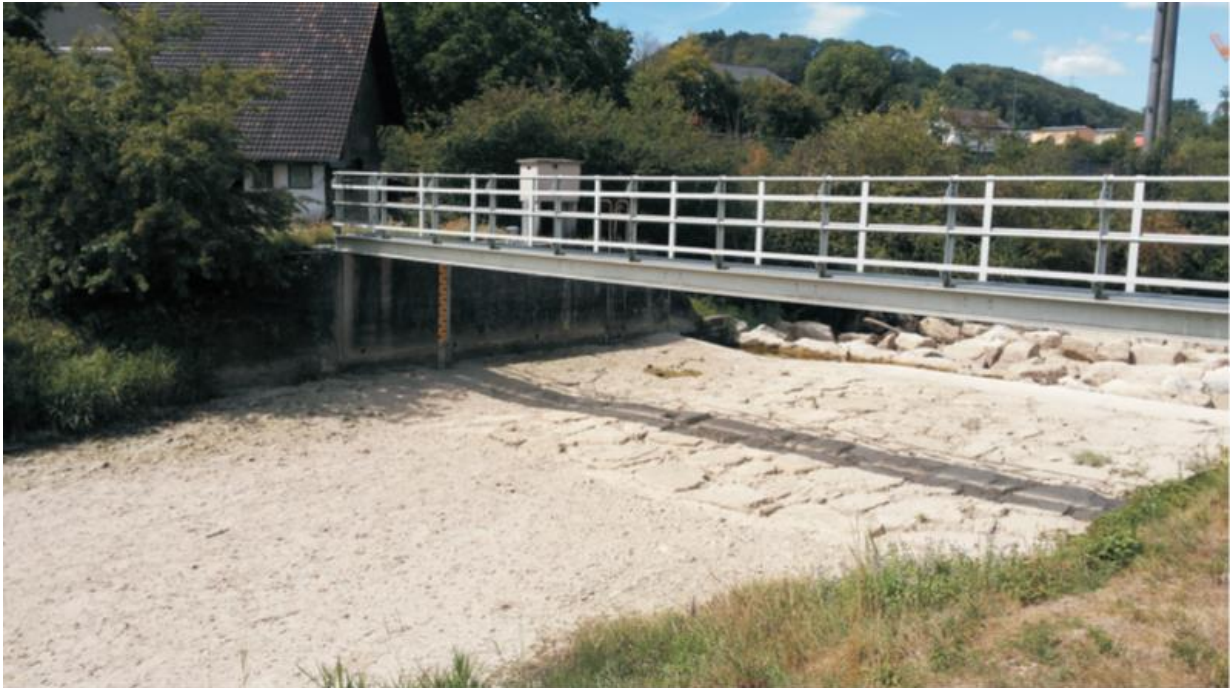
August 2018: Kein Tropfen Wasser mehr in der Sissle. Hinter der Brücke: Kasten der Messstation.(Bild Peter Lüscher)
